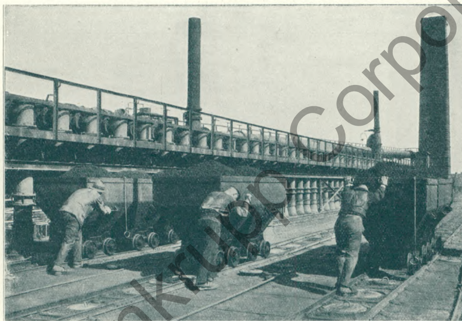
Abb. 5. Früher: Ofenfüllung durch Handarbeit. ist 13 m lang, 4 m hoch, 400 mm breit, besitzt also einen nutzbaren Rauminhalt von 19 cbm und faßt 15 t Kohle. Die Garungszeit beträgt 18 Stunden, das Koksabbringen rund 80% der eingesetzten Kohle, d. h. täglich 12 t Koks je Ofen. Daneben werden täglich je Ofen 500 kg Teer, 190 kg schwefelsaures Ammoniak, 100 kg gereinigte Benzole und bei völliger Beheizung mit Schwachgas das gesamte Destillationsgas von 5000 cbm gewonnen.
