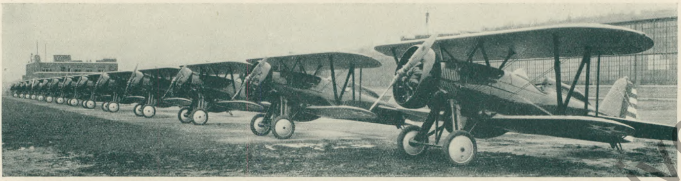
Abb. 2. Eine Staffel „Boeing P. 12 E.“. Kampfeinsitzer mit 450-PS-„Wasp“-Motoren. Diese Flugzeugtyp ist z. Bt. die schnellste und leistungsfähigste der amerikanischen Luftstreitkräfte. 135 dieser Jagdeinsitzer wurden jetzt bei der Armee, 145 Stück bei dem Marinekorps in Dienst gestellt.
