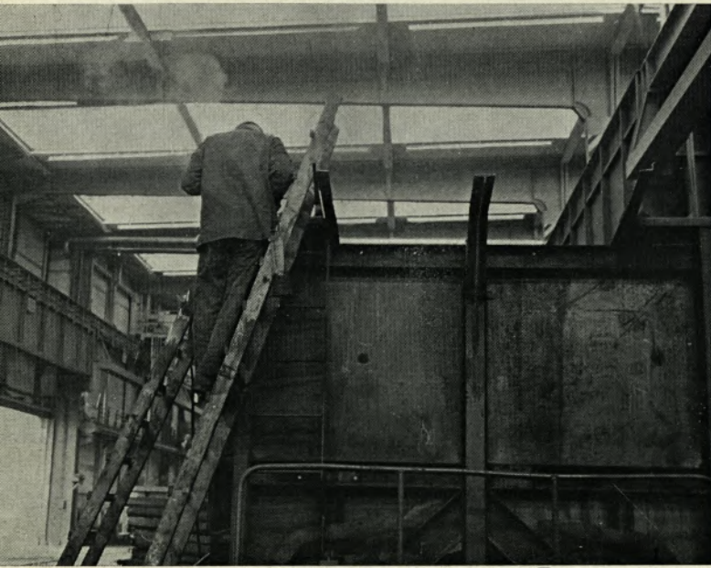
Bisher: Unfallgefährdetes Arbeiten mit Leitern an Stirn- und Seitenwänden von Oot- und Ot-Wagen.
