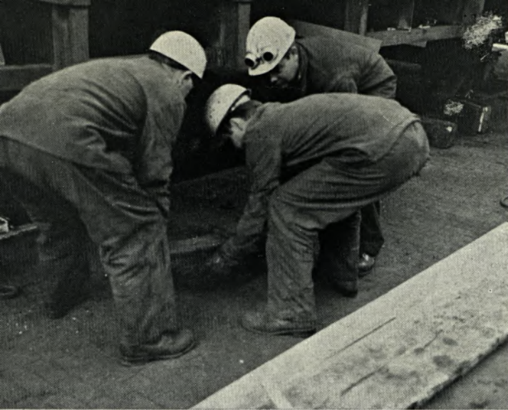
Bisher: Einbau einer Tragfeder.
