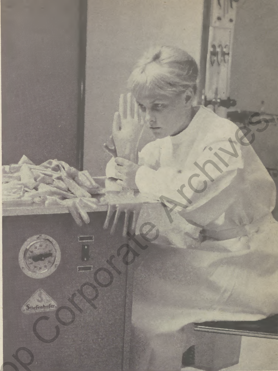
Heute stellt man höchste hygienische Ansprüche. Hier ist eine vollkommen neuartige Trocken-, Test- und Pudermaschine, mit der innerhalb von einer Stunde 50 Paar Gummihandschuhe bearbeitet werden können. Die junge Dame testet die getrockneten und gepuderten Handschuhe auf ihre Intaktheit. Fotos: dpa (3) (s. S. 94/95)
