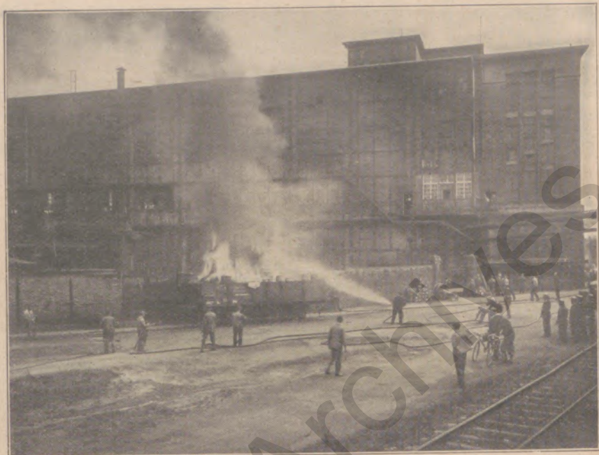
Löscharbeiten am brennenden Eisenbahnwaggon
