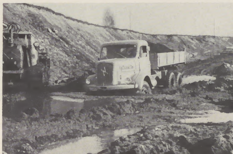
Bild 12 Einsatz eines HS 3-125 AK bei der Bayerischen Braunkohlen-Industrie in Schwandorf. Die Wagen müssen die im Tagebau geförderte Braunkohle durch ein ungeheuer schwieriges Sumpfgelände transportieren. Hierzu eignet sich vorzüglich der allrad-angetriebene 10,5 Tonner.
