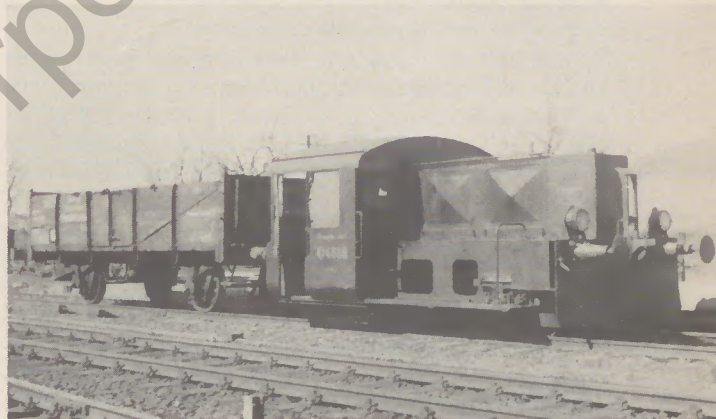
Bild 7 Diesel-Kleinlokomotive – Leistungsgruppe II mit mechanischer Kraftübertragung der ehem. Deutschen Reichsbahn-Gesellschaft (1934), Dienstgewicht 15 Mp, Leistung 70 PS, Spurweite 1435 mm
