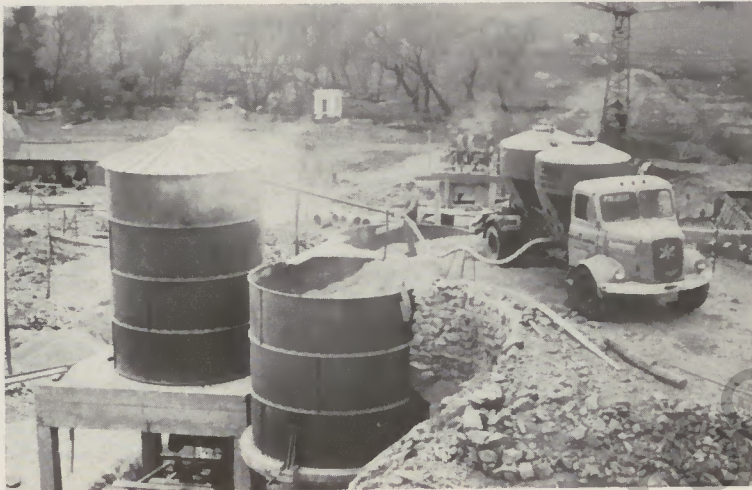
Bild 7 zeigt einen HS 120 als Silo-Fahrzeug beim Ablassen des Zements auf einer Baustelle in Buenos Aires.
