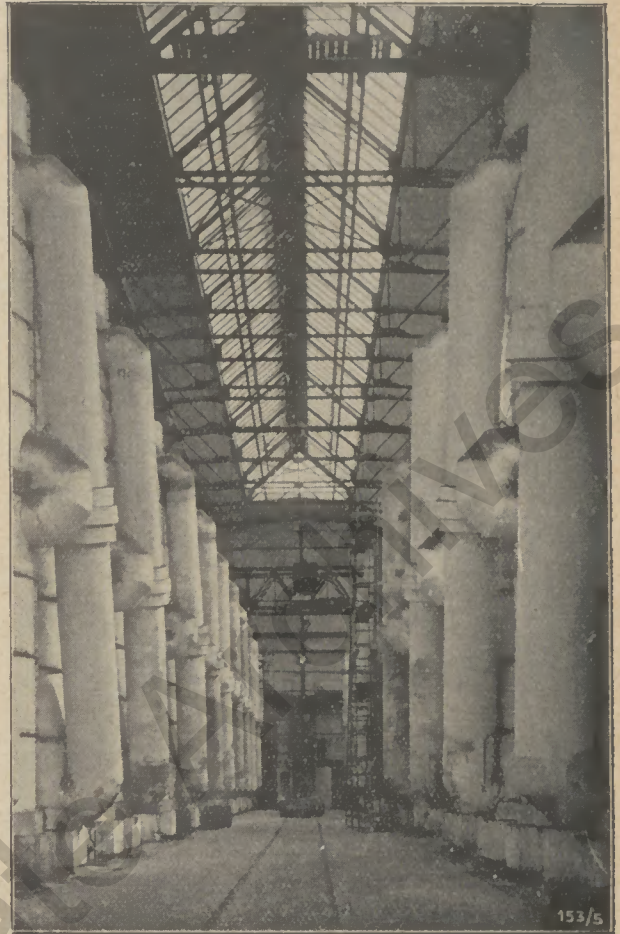
Blick in die Kontaktwasserstoff-Fabrik des Ammoniakwerkes Merseburg (Leunawerk)
