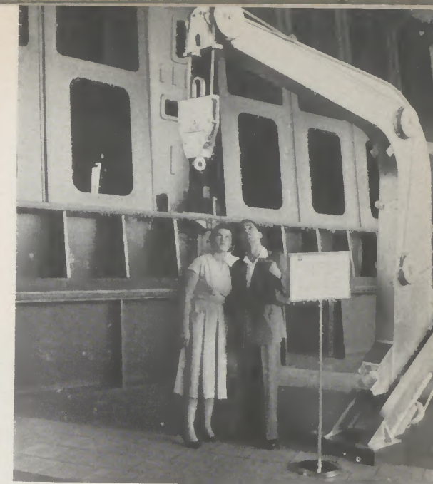
Zum Anhängen von Rettungsbooten: Das von den Presswerken Brackwede ausgestellte Davit zeugte vom hohen Stand der Leichtmetall-Schweißtechnik dieses Werkes
