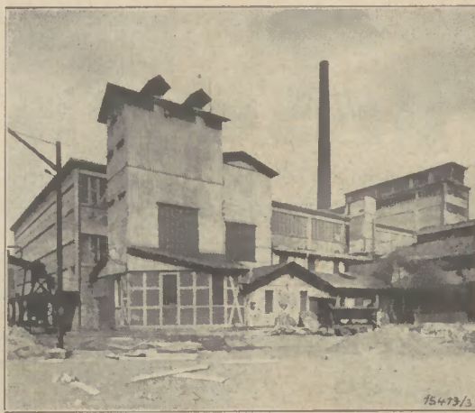
Abb. 6: Bauzustand am 18. April 28. Vereinigte Stahlwerke, A.-G., Hoerder Verein — Versuchsanstalt. Südwestliche Ansicht
