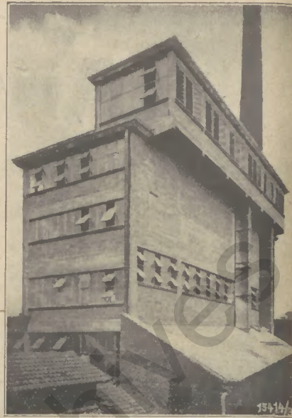
Abb. 7: Nordöstliche Ansicht des fertigen Bunkeraufbaues
