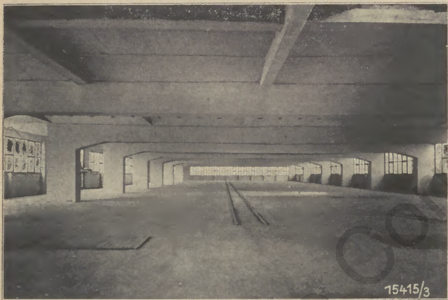
Abb. 8: Innenansicht der Steinfabrik im Rohbau fertig. Bauzustand am 18. 4. 28
