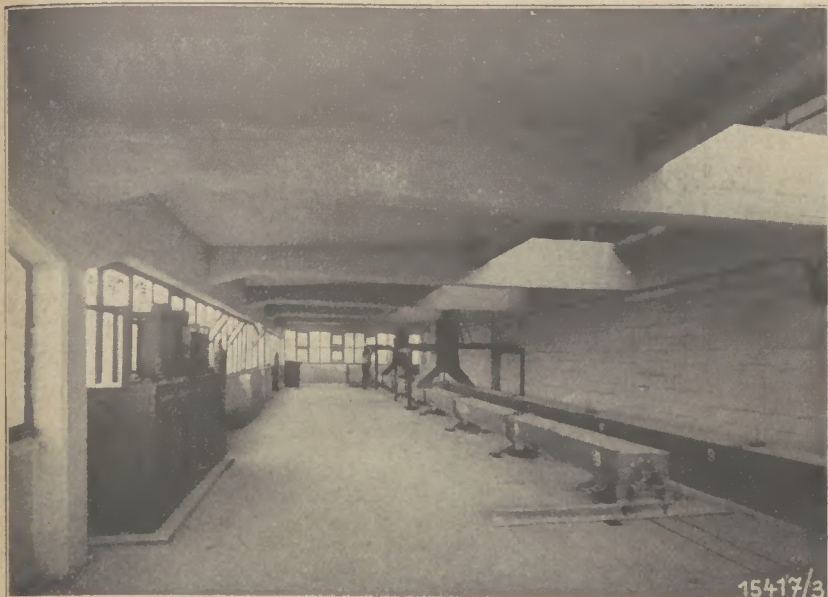
Abb. 10: (links oben) Innenansicht des mittleren Bunker- teiles, Transport- schnecken mit Schalt- anlage
