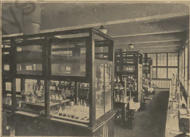
Blick in ein chemisches Laboratorium.
