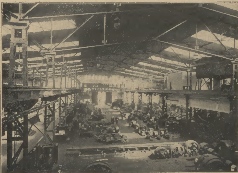
Der elektrische Betrieb der Dortmunder Union. Blick in die Werkstätte.
