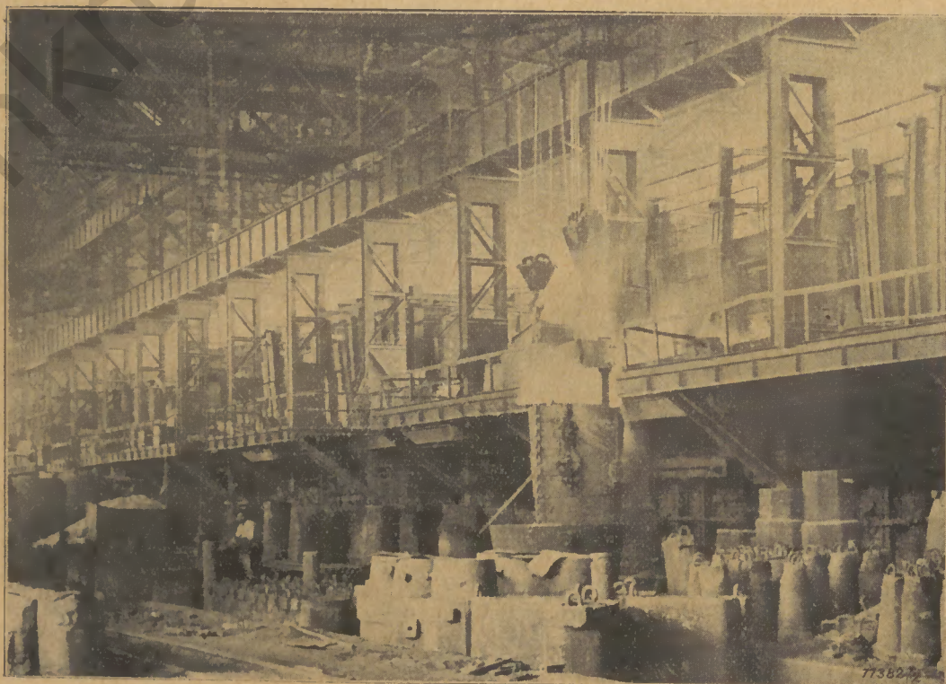
Bilder der Heinrichshütte von heute Martinstahlwerk, Dienabüsch
