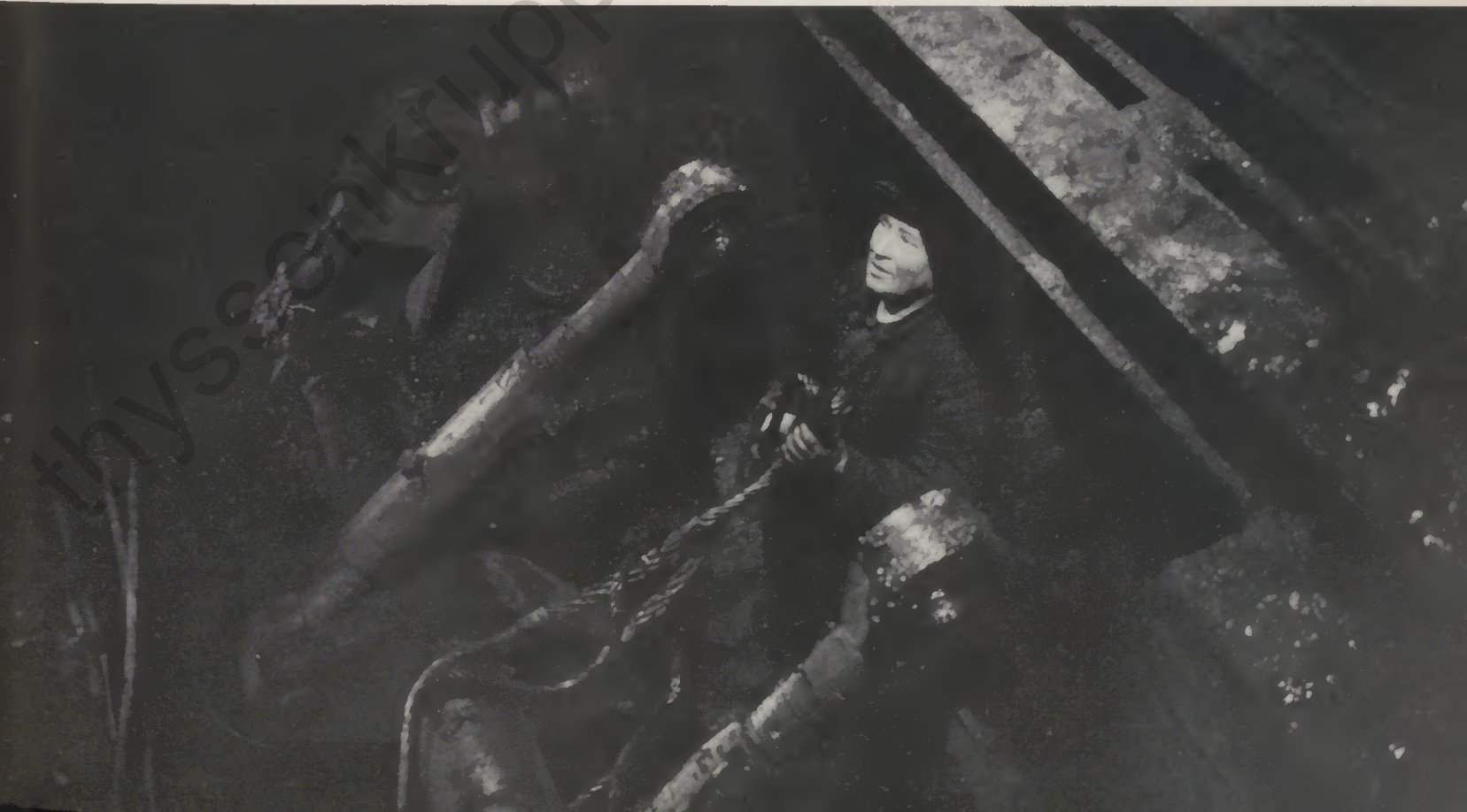
Arbeit unter Flur
