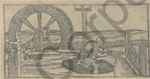
Abb. 4: Eisendrahtzug Biringuccios
