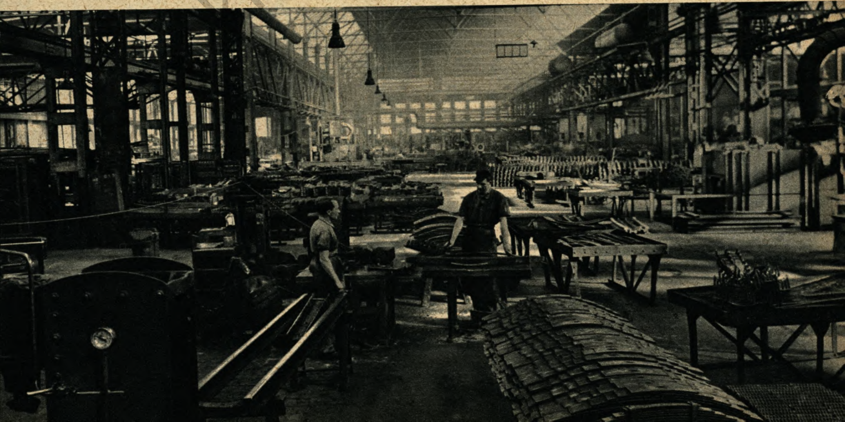
Ein Blick in die große Werkhalle des Federnwerks.
