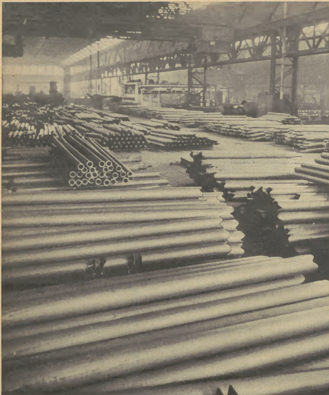
Blick in eine unserer beiden Rohrwerkshallen
