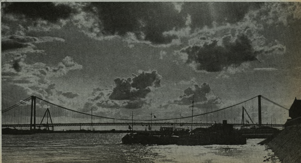
Die neue Rheinbrücke Emmerich—Kleve.
