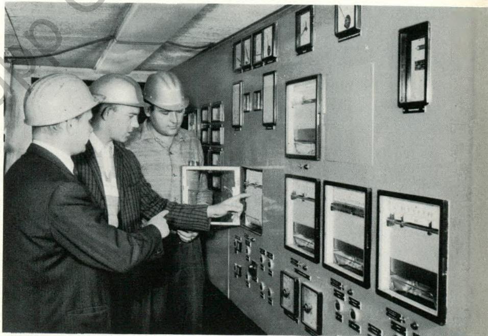
Zu unseren Aufgaben bei der Inbetriebnahme von Stahlentgasungsanlagen bei fremden Firmen gehört es, die Ingenieure dieser Firmen zuvor mit den Vorgängen bei der Stahlentgasungsbehandlung vertraut zu machen. Auf dem Bild sind zwei Ingenieure einer kanadischen Firma zu sehen, die bei uns für 14 Tage an der Stahlentgasungsanlage ausgebildet werden.
