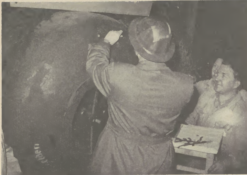
Werksleiter Dir. Meyer schlägt das amtliche Siegel des Technischen Überwachungsvereins in den neuen Kessel
