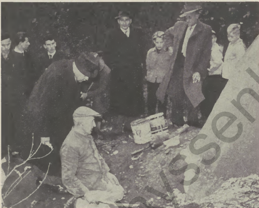
Schmelzmeister Jung beim Abdichten der durch die Hitze entstandenen Risse im Ofenmantel
