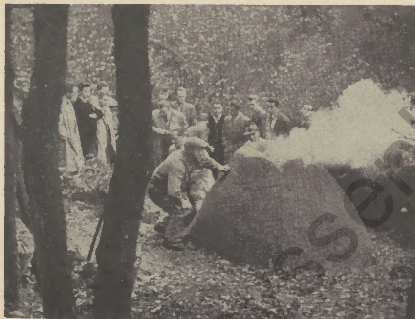
Der Rennofen während der Versuchsschmelze
