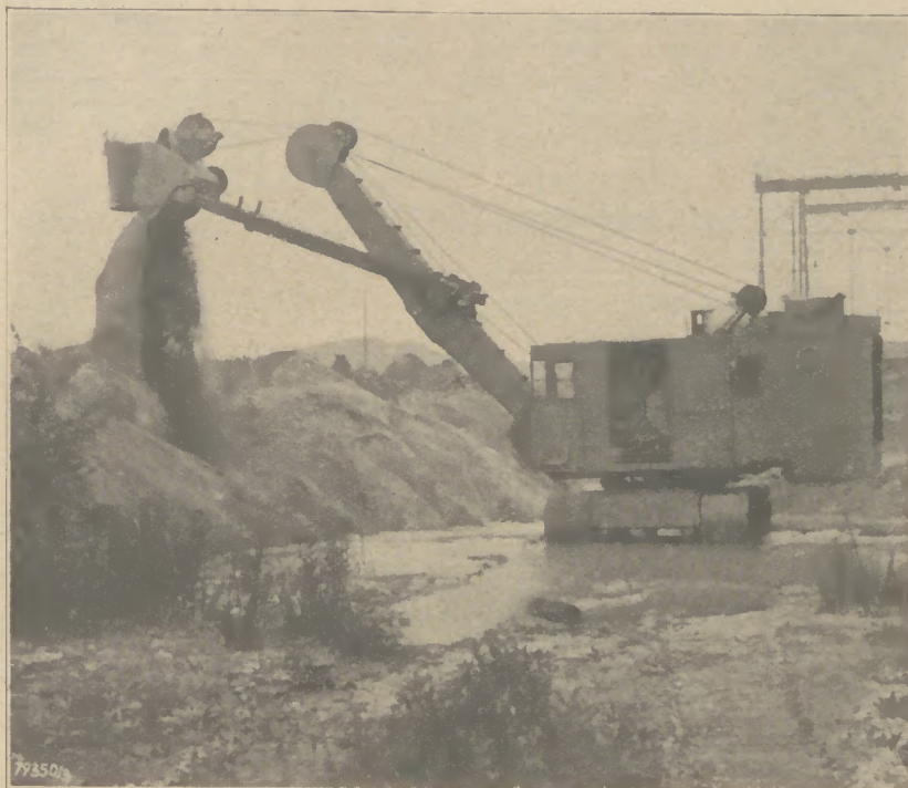
Im Hüttengelände: Bagger bei der Arbeit
