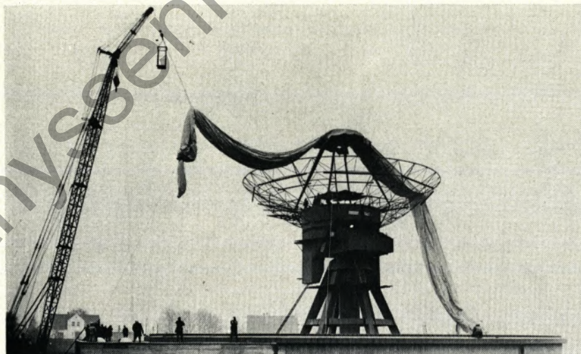
Beim Bau eines neuen Parabolspiegels für die Bochumer Sternwarte war unser Unternehmen mit Rohren für eine Stahlrohr-Fachwerkkonstruktion vertreten. S. 26
