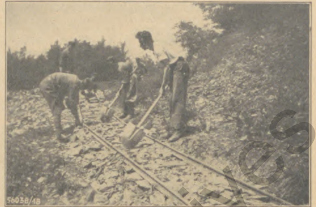
Schienen werden verlegt
