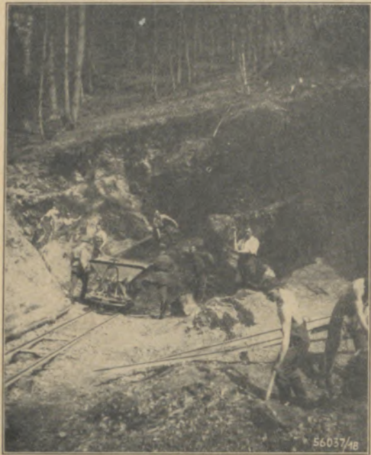
Arbeitsvolk bauen eine Wendeplatte
