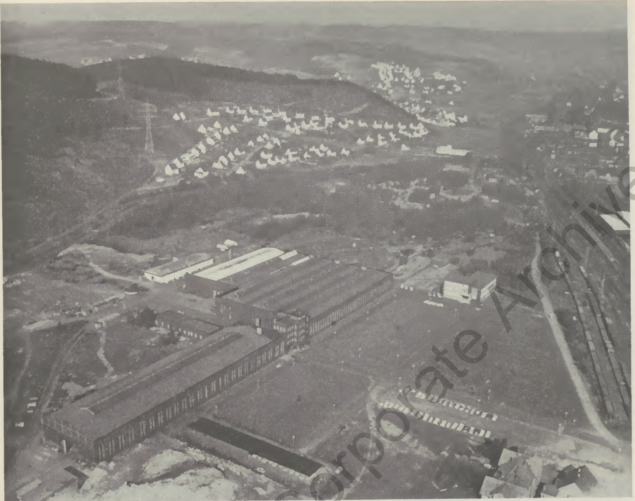
Die Werkhallen der Blefa (Vordergrund) auf dem 275 000 qm großen Firmengelände; rechts die Bahnlinie Hagen-Siegen-Frankfurt/M. (Freigabe-Nr. 2624/66)
