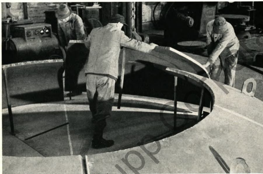
Gutes Fingerspitzengefühl beweisen die drei Facharbeiter Werner Brahm, Gustav Dehn und Josef Steden beim Zusammenbau. Hier muß Millimeterarbeit geleistet werden, um ein einwandfreies Werkstück zu erhalten
