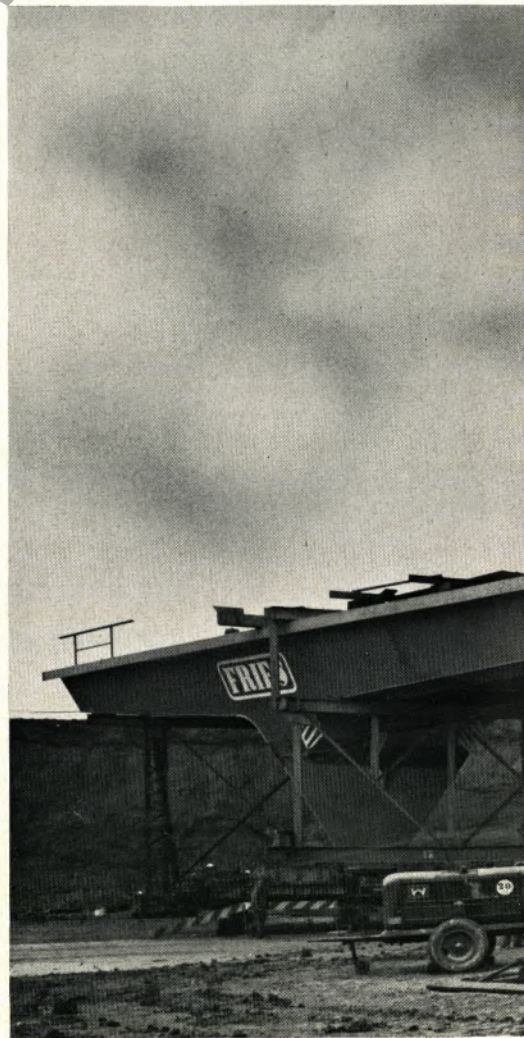
Der Ausbau des Rhein-Main-Schnellweges machte es notwendig, die alte Eisenbahnbrücke der Bundesbahn Frankfurt (Main)—Höchst—Bad Soden, in der
