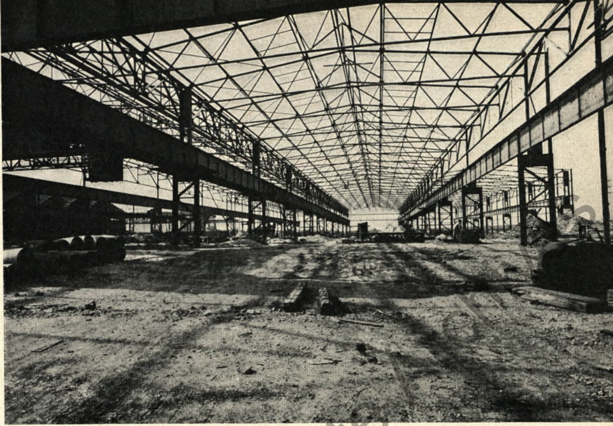
Auf einer Fläche von 18 000 Quadratmetern wird im Werk Thyssen eine neue Schweißstraße für Rohre von 6 bis 16 Zoll errichtet. Sie soll in diesem Jahr noch in Betrieb genommen werden. Das eindrucksvolle Foto zeigt die Stahlkonstruktion einer der neuen Hallen
