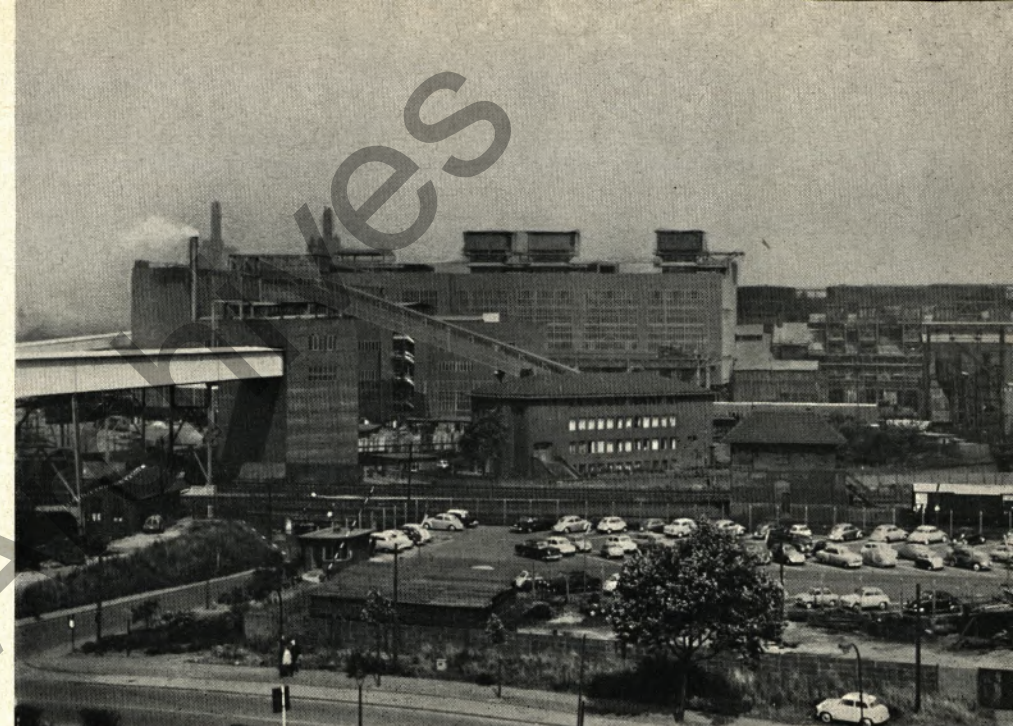
Gesamtansicht unseres Blastahlwerkes vom Nordhafen aus gesehen. Deutlich erkennt man die Konverterkamme. Das rechts im Bild sichtbare alte Thomaswerk II veranschaulicht gut die Größenunterschiede
