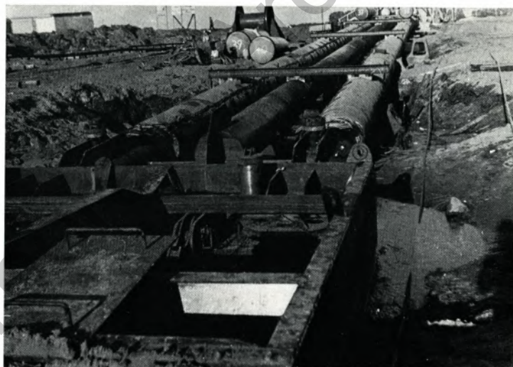
Dükerkopf mit Zugschlitten.
