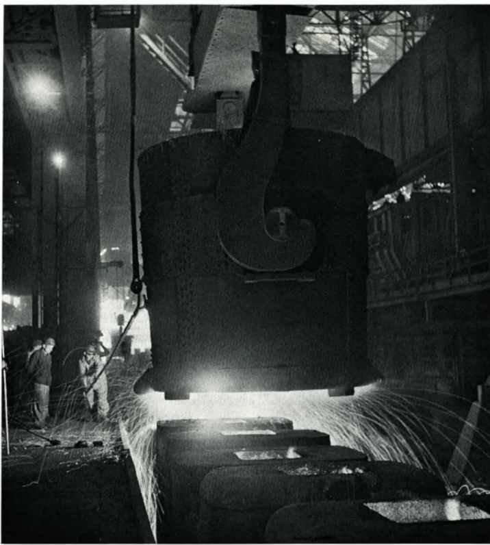
Rückseite des Ofens. Vergießen nach dem Abstich. Links neben der Pfanne der Pfannenmann. Mit dem langen Hebel bedient er den Pfannenstopfen.
