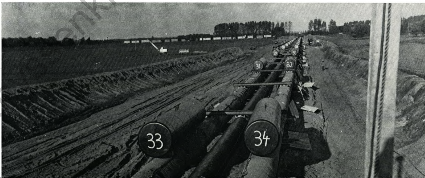
Blick auf den fertig montierten Düker vor dem Ziehen.
