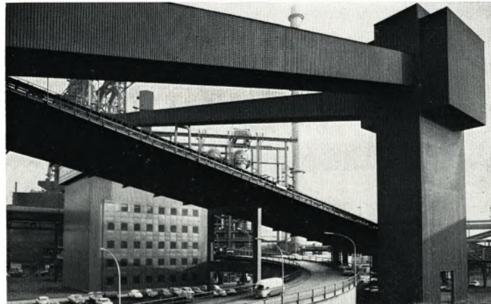
Das zentrale Meßhaus mit den Zufuhrbändern zur Bunkeranlage und den Bandbegichtungsbrücken.
