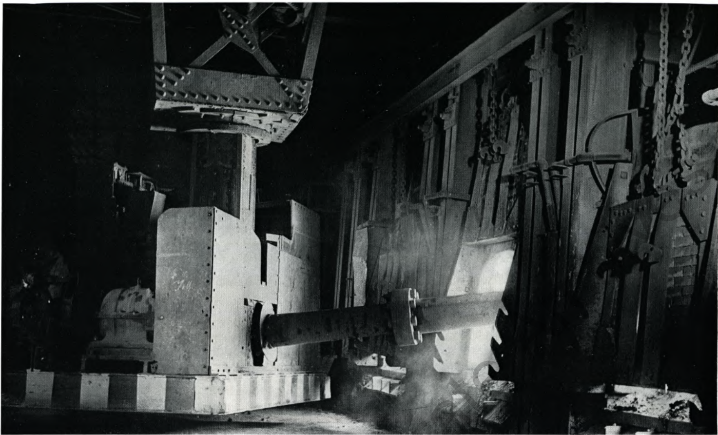
Vordere Seite des Ofens. Beschickung des Ofens mit Schrott. Der Schrott wird mit einer Mulde in den Ofen gekippt.
