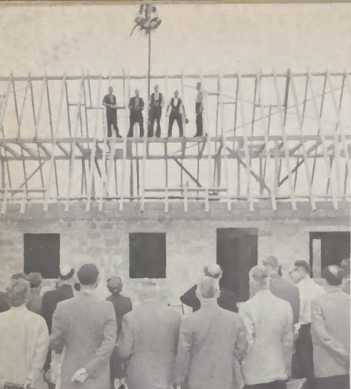
Das Richtfest ist in vollem Gange. Nach den feierlichen Reden folgt jetzt der frohe und besinnliche Richtspruch hoch oben vom First des Hauses.
