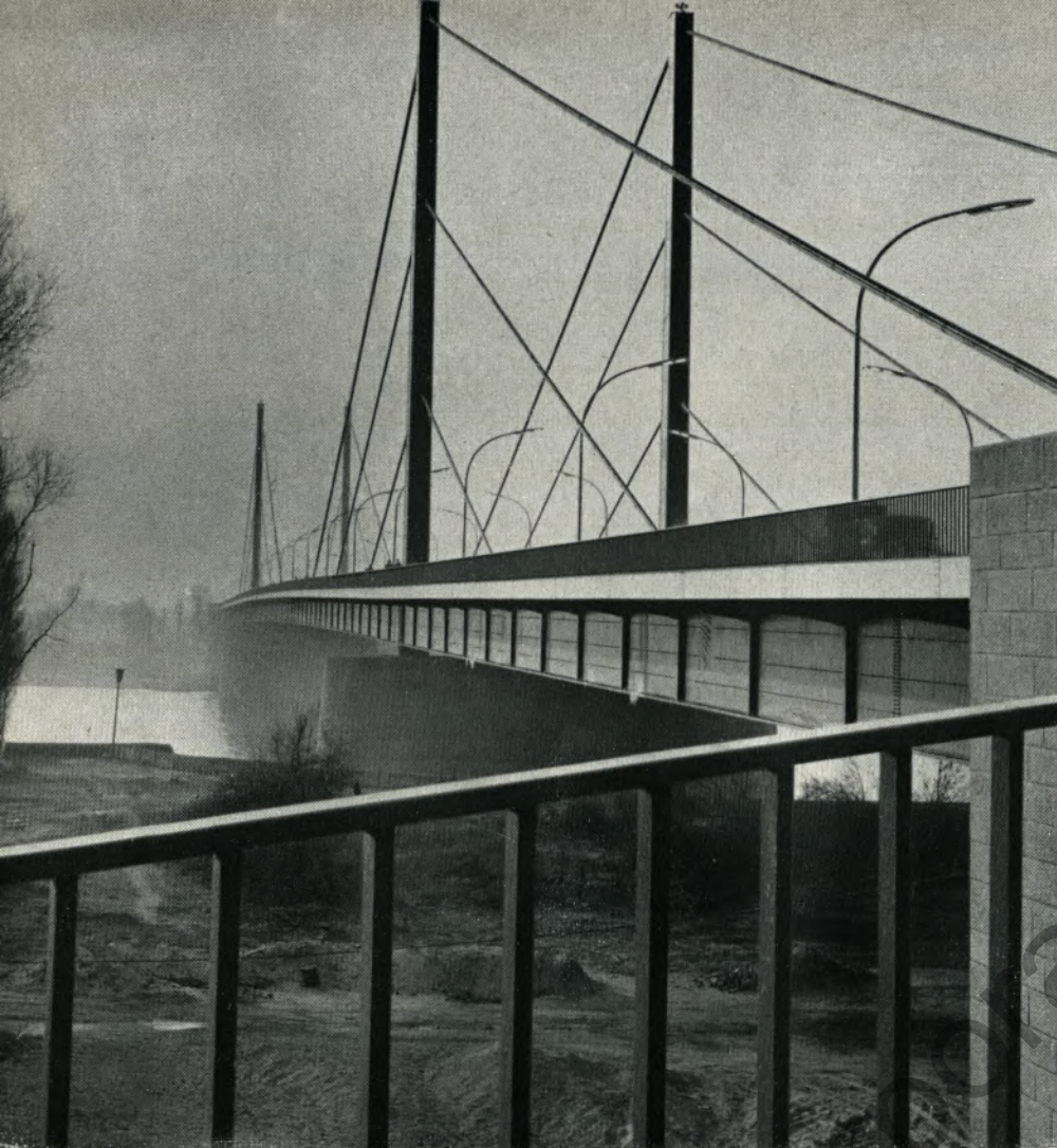
Die Düsseldorfer Nordbrücke ist wegen ihrer architektonisch kühnen Form überall bekannt geworden
