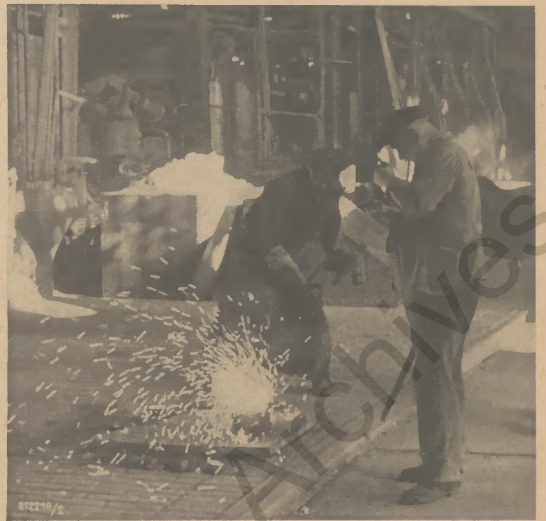
Oben rechts: Stahlprobe vor einem Martinofen
