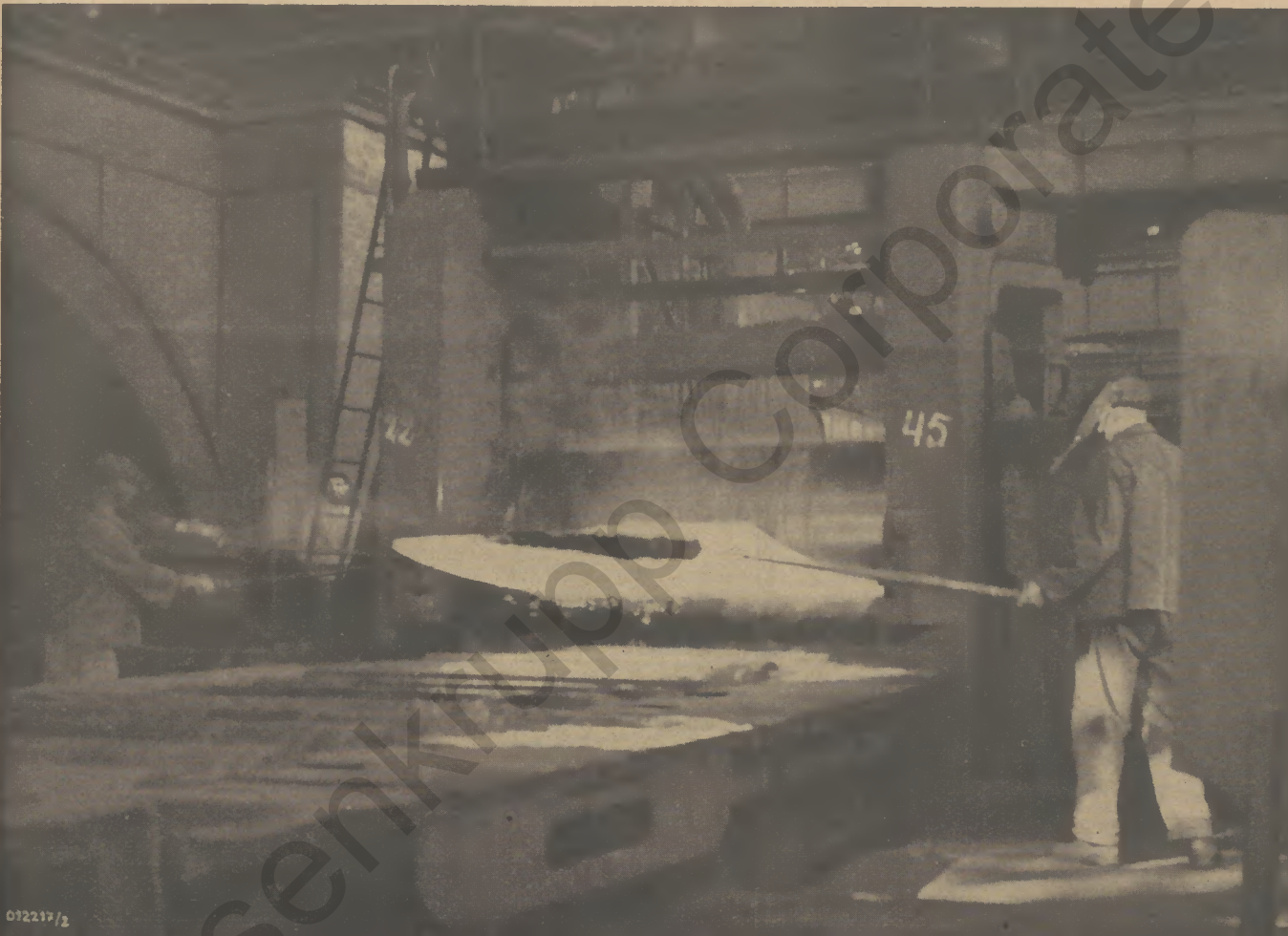
Oben rechts: Stahlprobe vor einem Martinofen
