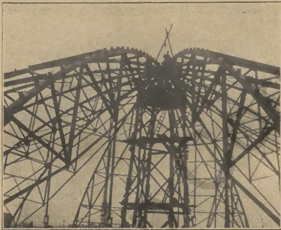
Der Firstpunkt im Eisengerüst des Planetariums, mit dem großen Stahlbolzen.
