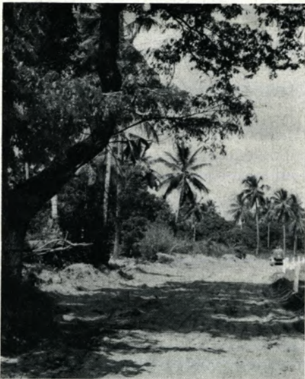
Im Bau befindliche Zufahrtsstraße zur Düngemittelfabrik.
