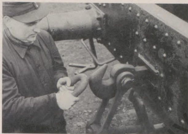
Abb. 4: Falsches Anfassen des Kupplungsbügels
