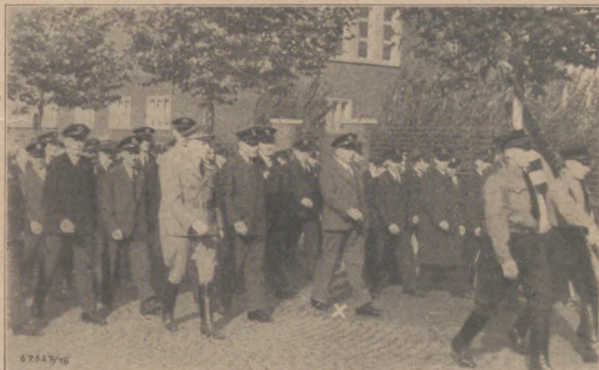
Aufn.: Heinz. Bode, Brückenbau
