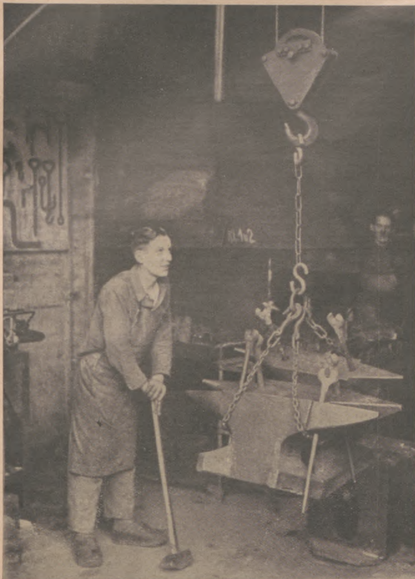
Zerreißprobe an einer Kette
