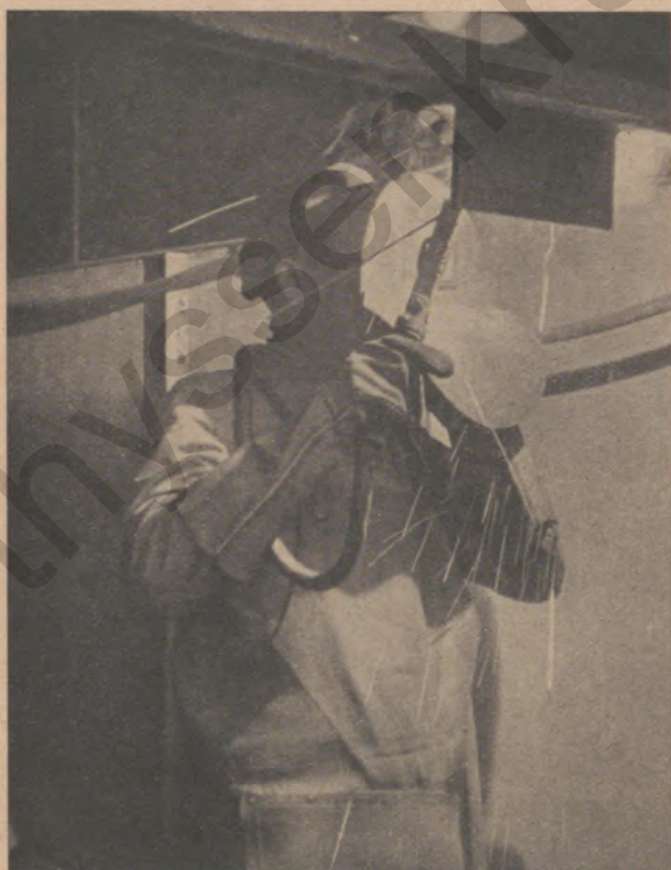
Ueberkopfschweißen einer Kehlnaht; Stahlbau Schlosserlehrling, drittes Lehrjahr
