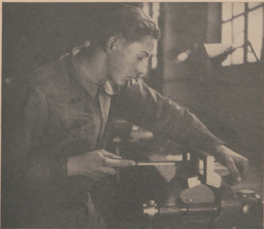
Feilarbeit: Schalen und Schalensteine aus VTE2-Stahl mit 110—125 kg/mm 2 Zugfestigkeit
