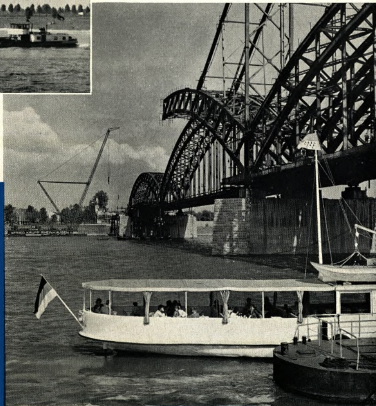
Das ist die formschöne Düsseldorfer Nordbrücke. Die Phoenix-Rheinrohr AG lieferte dafür 1905 t Sonderstahl HSB 50 und 200 t normalen Baustahl St 37
