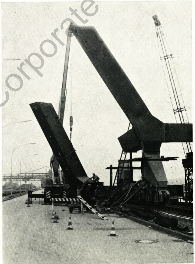
Eine Stütze des Tragwerkes wird angeschlagen.
