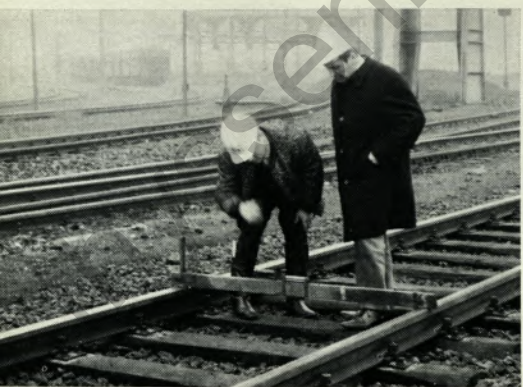
Überprüfung der gegenseitigen Höhenlage der Schienen mit der Wasserwaage.
