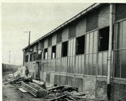
Halle 17 während des Umbaus zur Mech. Werkstatt.
