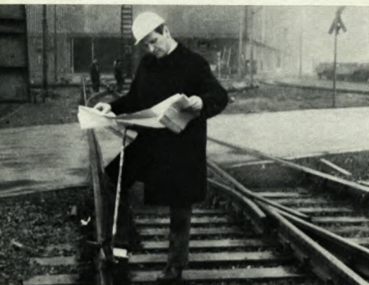
Bahnbauingenieur Herbers bei der Aufmaßüberprüfung mit Hilfe eines Tachometriergerätes.
