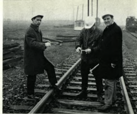
Mit Hilfe einer Pfeilhöhenmessung wird am Ablaufberg Meerbergstraße die richtige Lage des Gleisbogens geprüft. (Siehe auch Bild der mittleren Spalte.)
