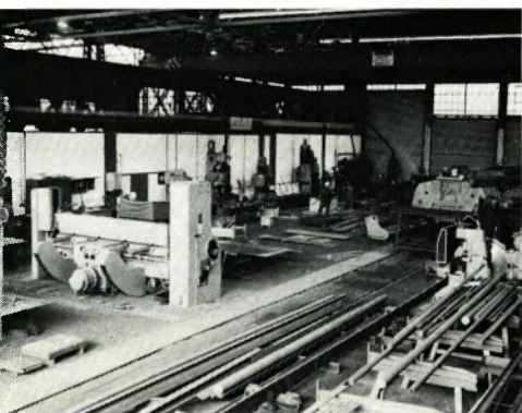
Halle 9 nach der Umgestaltung als Vorfertigungswerkstatt. (Vorn links die Abkantpresse, dahinter die Bohrmaschinen, vorn rechts die Säge, dahinter die Hydraulik-Reparatur).
