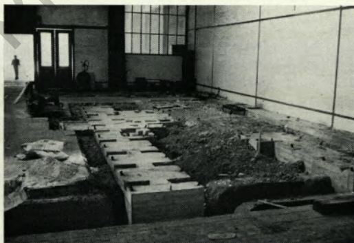
Halle 16 Nordende der Radsatzwerkstatt während des Umbaus für die Mechanische Werkstatt.
