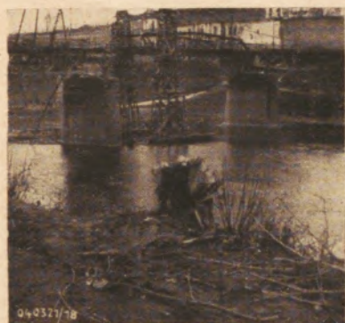
Die Dnjeprbrücke während der Montage
