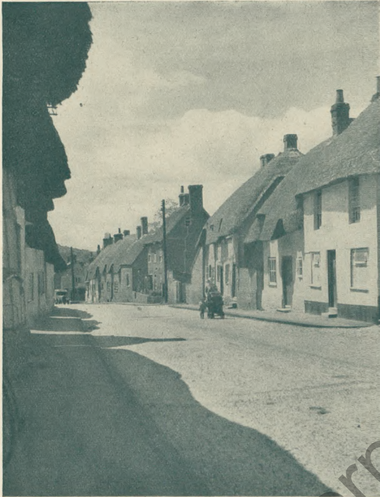
„Die Bauernhäuser sind hier alle mit Stroh gedeckt.“
