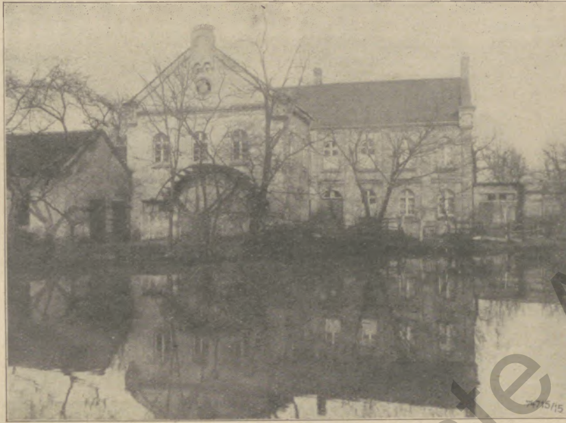
Moriansmühle in Neumühl
