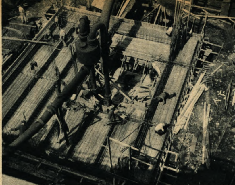
Blick auf die Baustelle des neuen Zweiseil-Förderturms auf der Zeche Kaiserstuhl
