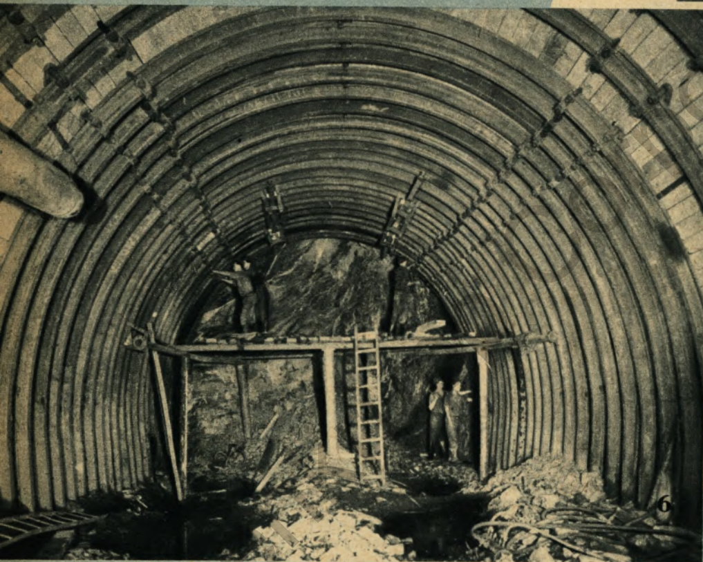
Mit modernen Abbauvorrichtungen wird auf unseren Schachtanlagen Kohle gewonnen. Für den Grubenausbau wird Material verwandt, das in unseren Verarbeitungsbetrieben hergestellt wird, so z. B. der Radbod-Stempel auf diesem Bild, der auf unserer Schachtanlage Fürst Leopold-Baldur aufgenommen wurde.
