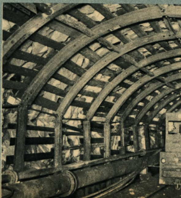
4 Zum Programm der Lorenz-Polygon-Ausbau GmbH gehört auch der kombinierte Lorenz/Toussaint-Heintzmann-Polygonausbau mit einem nachgiebigen Segment aus TH-Profilen und einem starren Gegensegment, wie auf diesem Bilde dargestellt.
