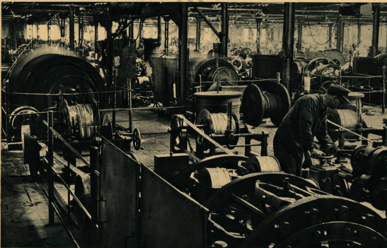
Teilansicht der Drahtseilerei für schwere Drahtseile
