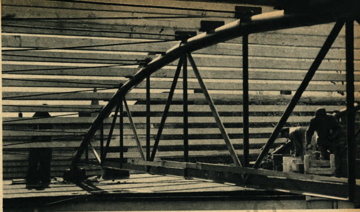
Die leichte jedoch tragsichere Konstruktion des Röhrenbinders läßt sich schnell montieren und ausrichten
