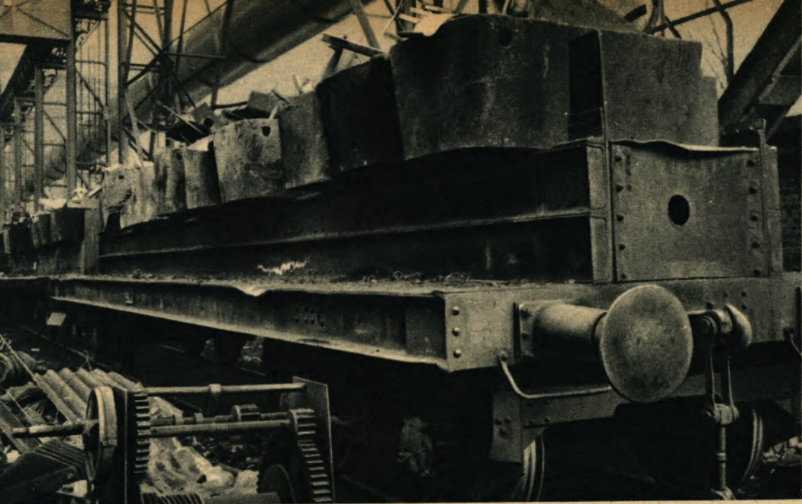
Einsatzbereit stehen auf dem Schrottplatz der Westfalenhütte die beladenen Transportwagen zum Beschicken der Siemens-Martin-Öfen
