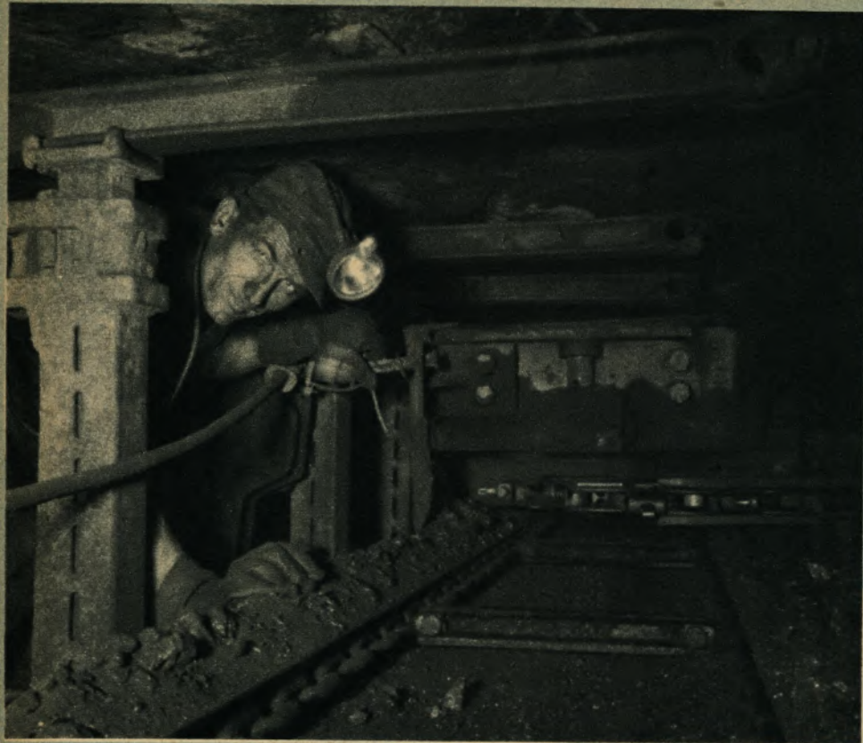
Mit modernen Abbauvorrichtungen wird auf unseren Schachtanlagen Kohle gewonnen. Für den Grubenausbau wird Material verwandt, das in unseren Verarbeitungsbetrieben hergestellt wird, so z. B. der Radbod-Stempel auf diesem Bild, der auf unserer Schachtanlage Fürst Leopold-Baldur aufgenommen wurde.
