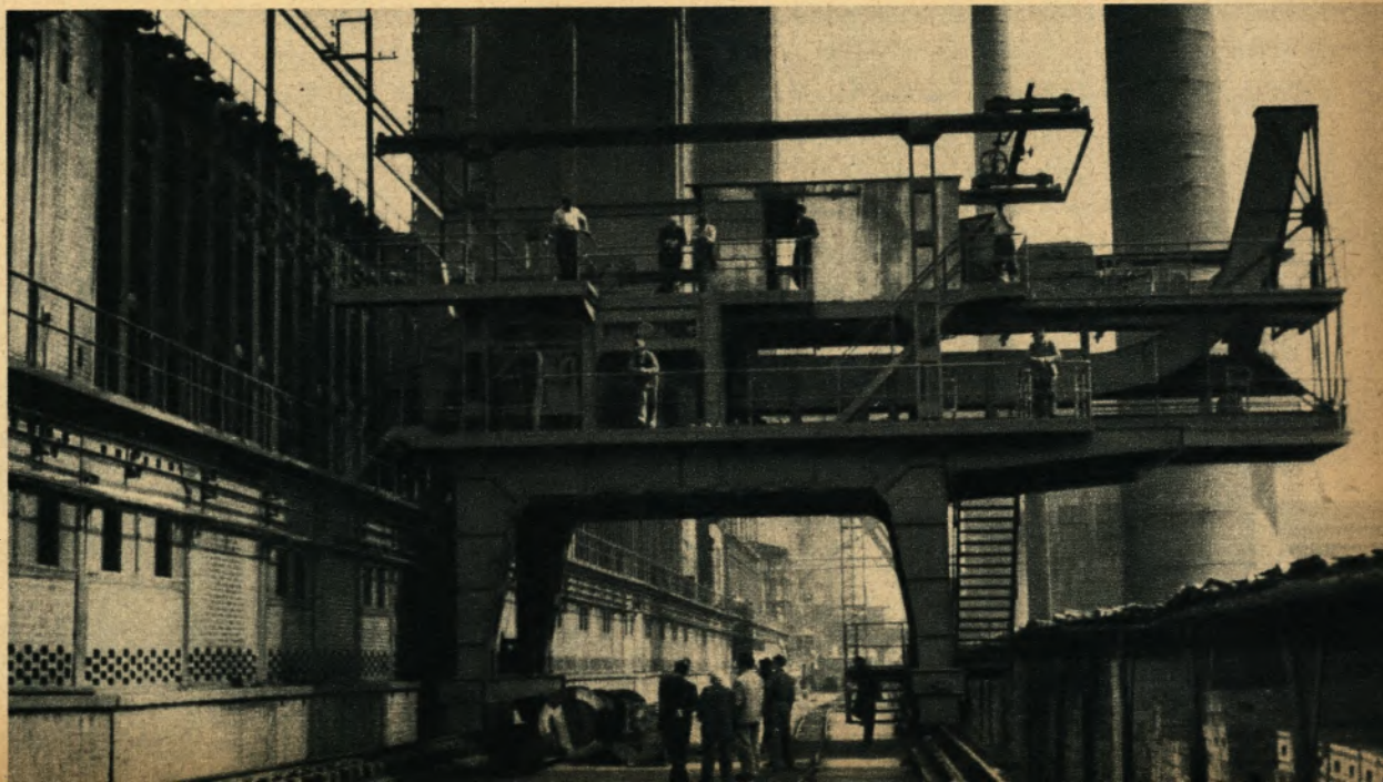
Ausdrückmaschine mit geschweißtem Portal. Erste Ausführung von M. F. D. Dortmund hergestellt
