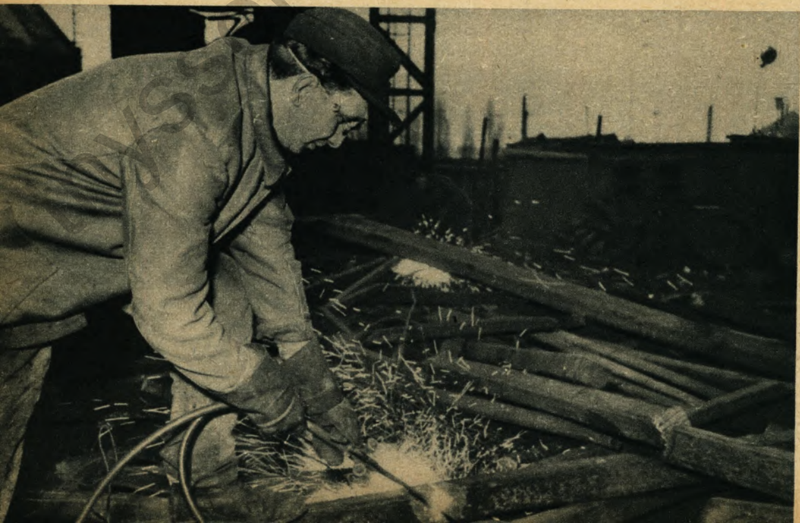
Mit dem Schneidbrenner werden große Schrottstücke für den Einsatz im S. M.-Ofen chargierfähig zerschnitten
