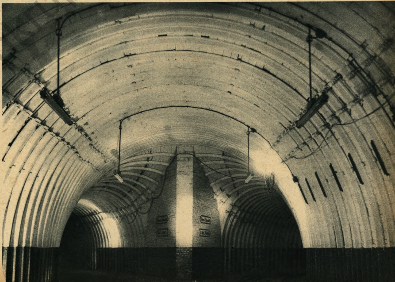
Bild 3 Streckenabzweig vom Füllort zu den Richtstrecken
