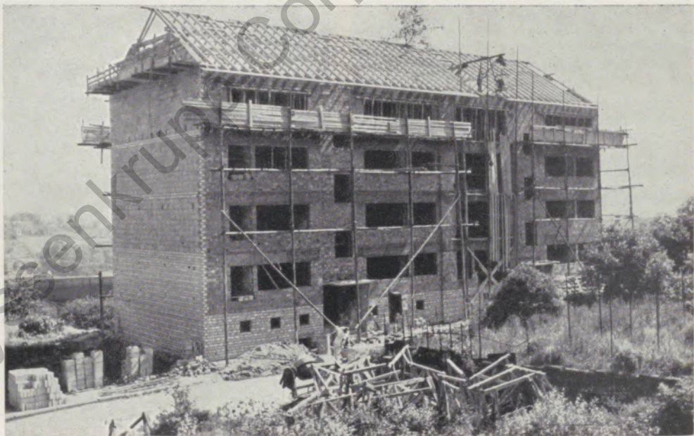
Richtfest des Wohnungsneubaus in der Johannesstraße der Gemeinnützigen Kleinwohnungsbau-Gesellschaft
