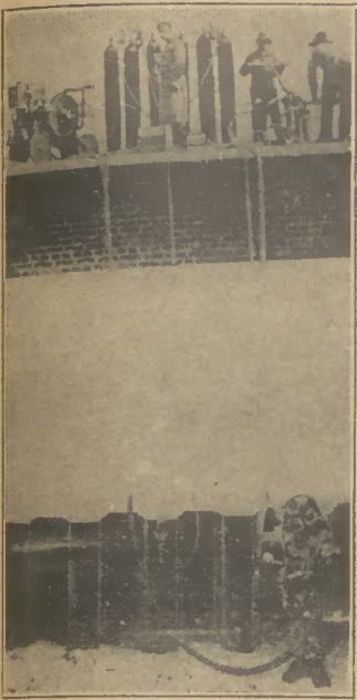
Gesamtarbeitsanordnung beim Unterwasserschneiden.
