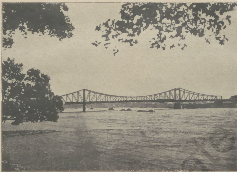
Abb. 2: Rheinbrücke bei Düsseldorf-Neuß; erbaut von der Dortmunder Union
