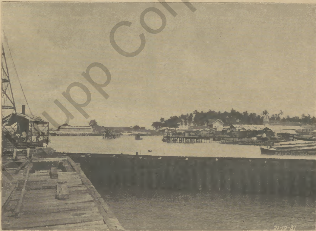
Reirand aus Stahlspundbohlen Larssen in Cabedello (Brasilien)
