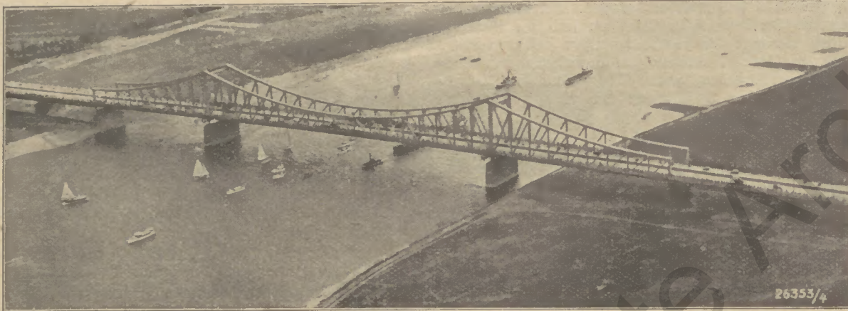
Luftaufnahme der neuen Rheinbrücke in Düsseldorf-Neuss aus Union-Baustahl der Dortmunder Union
