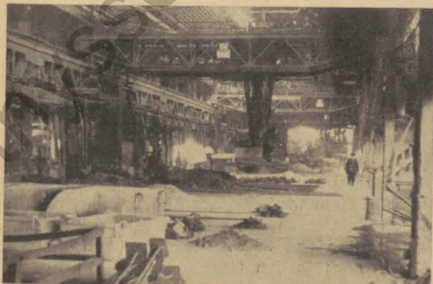
Blick auf die Ofenbühne eines SM-Stahlwerkes
