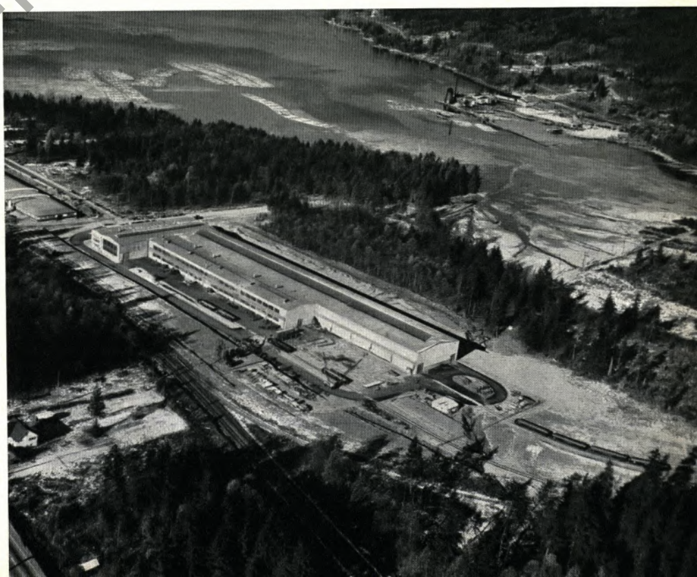
Fast unmittelbar an einem Meeresarm des Pazifik liegen die modernen Produktionsstätten unserer Tochtergesellschaft, der Canadian Western Pipe Mills Ltd. in Port Moody, die diese Luftaufnahme zeigt
