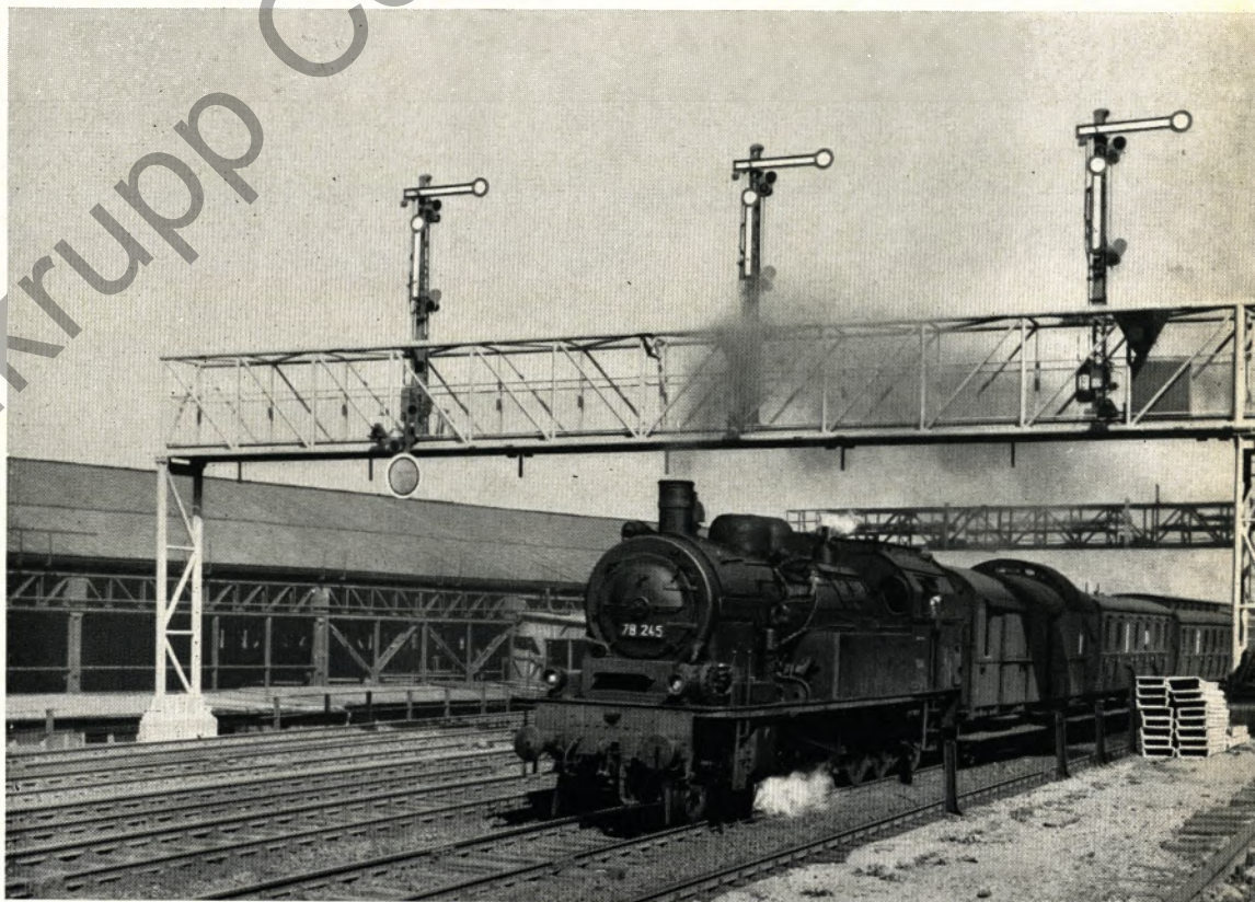
Man sieht es der Signalbrücke aus Rohr nicht an, daß sie bei Nacht und Nebel montiert wurde. In der kurzen Zeit von eineinhalb Stunde ist sie von einem Kran auf die Stützen gehoben und dann von unseren Monteuren verschraubt worden
