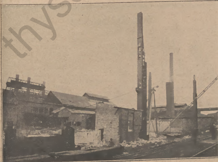
Abb. 5: Aufstellung der beiden ersten Säulen der Halle II. (3. 4. 25)
