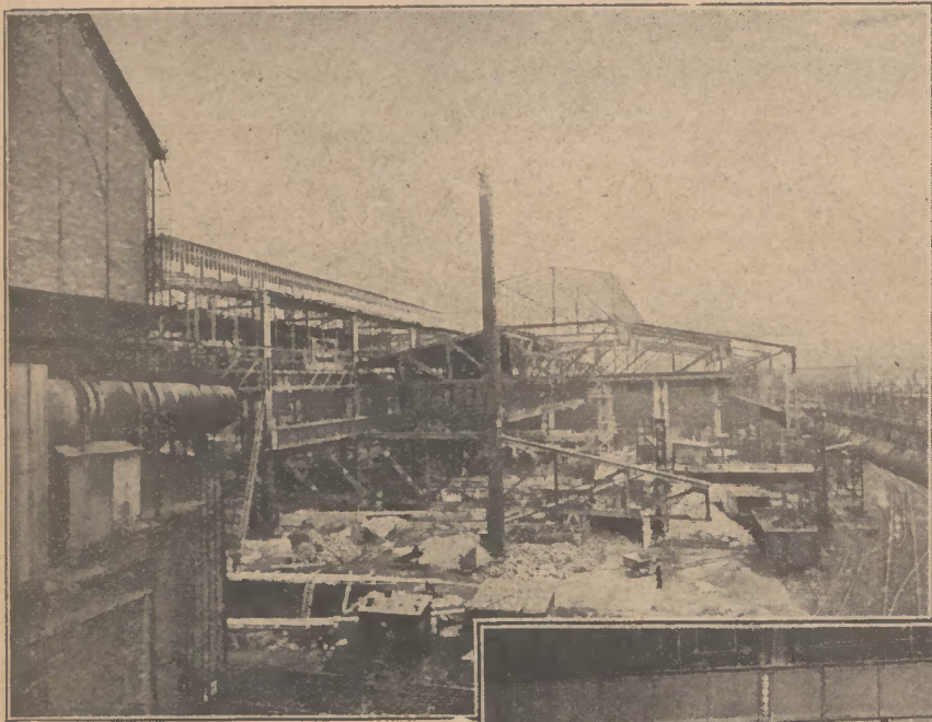
Abb. 7: Montage der Halle 1. Beginn des Raminbaues (S. 8. 25).
