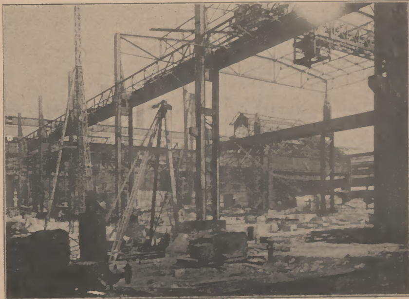
Abb. 6: Montage der Halle II (vom Hauptweg aus gesehen). (16. 5. 25)
