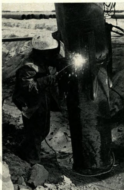
Rückseite: Beim Ausbau des Emdener Hafens werden zum erstenmal spiralgeschweißte Rohre aus unserem Baroper Rohrwerk als Gründungspfähle verwendet. Unser Bild zeigt das Schweißen der Verbindung zweier Spiralrohre im Fundament für eine Kranbahn im neuen Erzlager.
