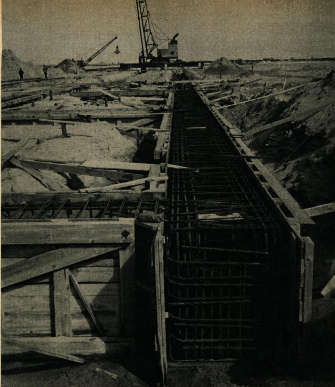
▲ So sieht das weite Baugelände am Südkai mit den in Bau befindlichen Fundamenten für eine Laufbahn aus, auf der später die Erzverladebrücke hin- und herrollen wird
