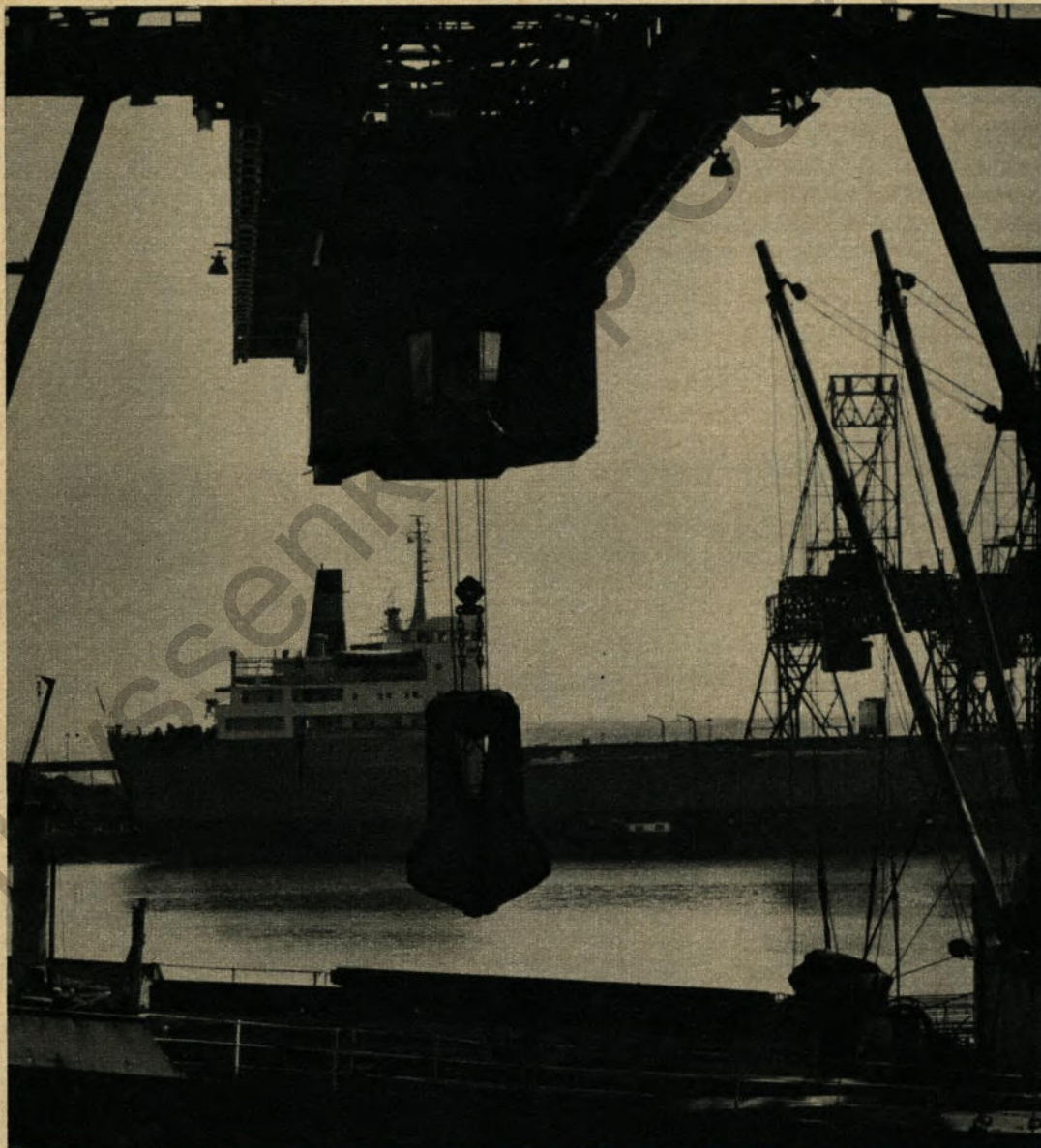
▲ Dieser Blick vom neuen Lagerplatz auf die schon fertige Pier des Südkais erfaßt im Vordergrund die Fundamente für die neue Waggonbeladestation und zeigt im Hintergrund Verladebrücken über einem zu entleerenden Erzdampfer
