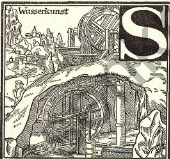
Alte Vorrichtung zum Heraus-pumpen des Grubenwassers
